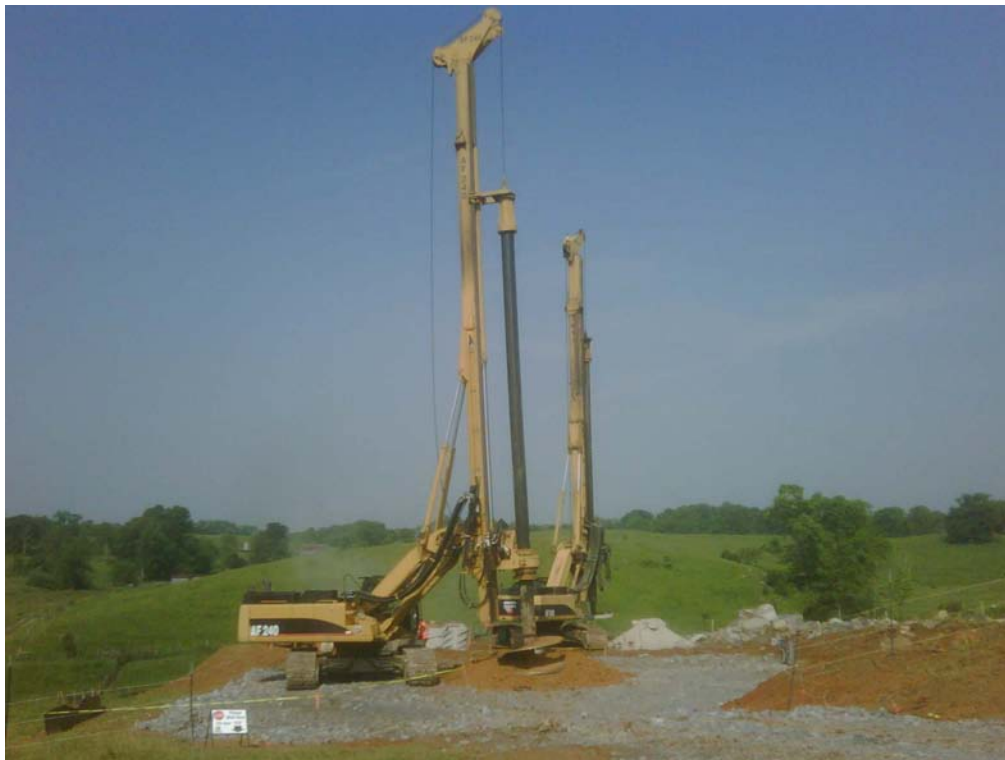
Figure 5 – IMT AF 240 Drill Rig
